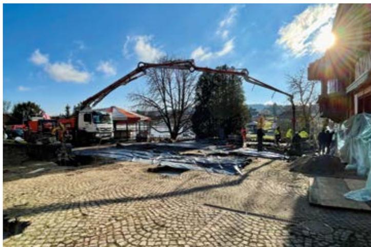
Um die Fundamente für die Sicht- und Sonnenschutzsysteme zu gießen, wurde eine Betonpumpe mit einem 24 Meter langen Schwenkarm eingesetzt.
