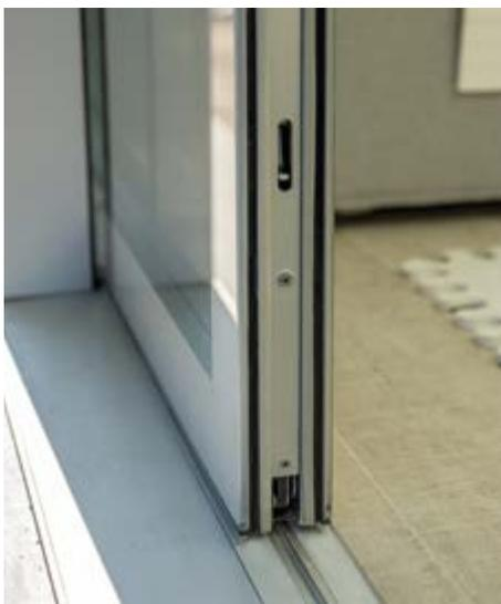
Bei den Ganzglasflügeln bildet speziell gehärtetes, eisenarmes und umweltzertifiziertes Glas flächenbündige Oberflächen.
