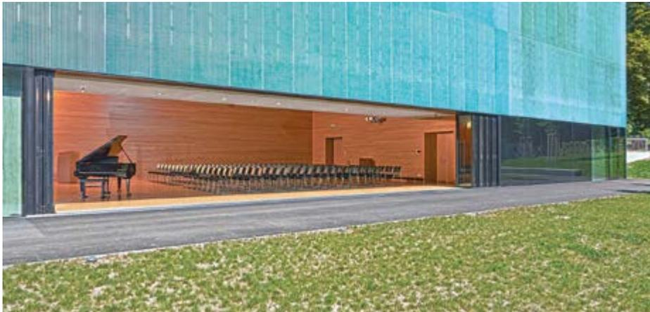
Glas-Faltwände ermöglichen im Schulhaus für Kunst und Musik in Lörrach eine variable und großzügige Öffnung der Fassade ohne Stützen über fast 16 Meter.
