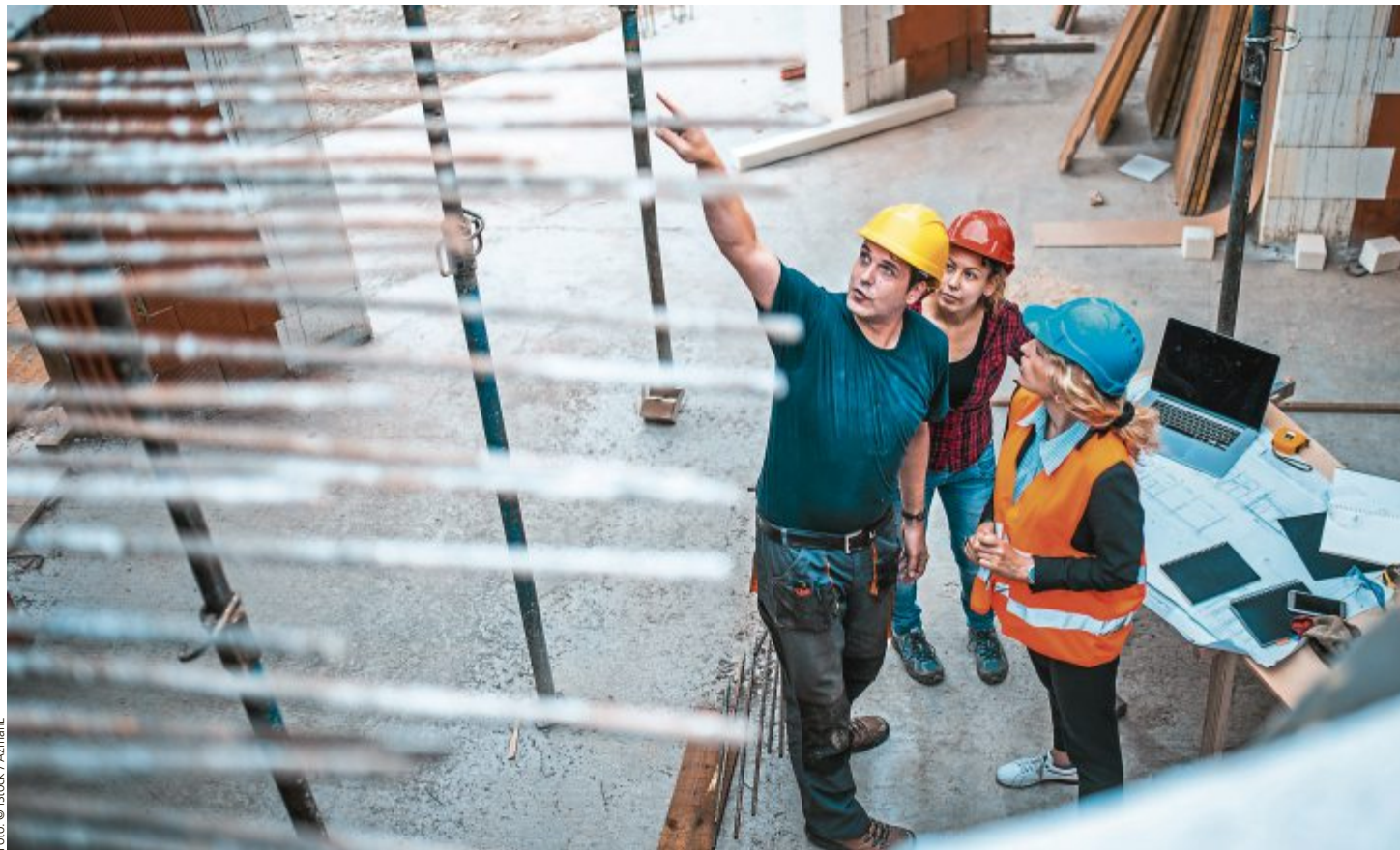
Der Handwerker muss die Arbeit der Firmen prüfen, die vor ihm gearbeitet haben, und gegebenenfalls seine Zweifel melden.
