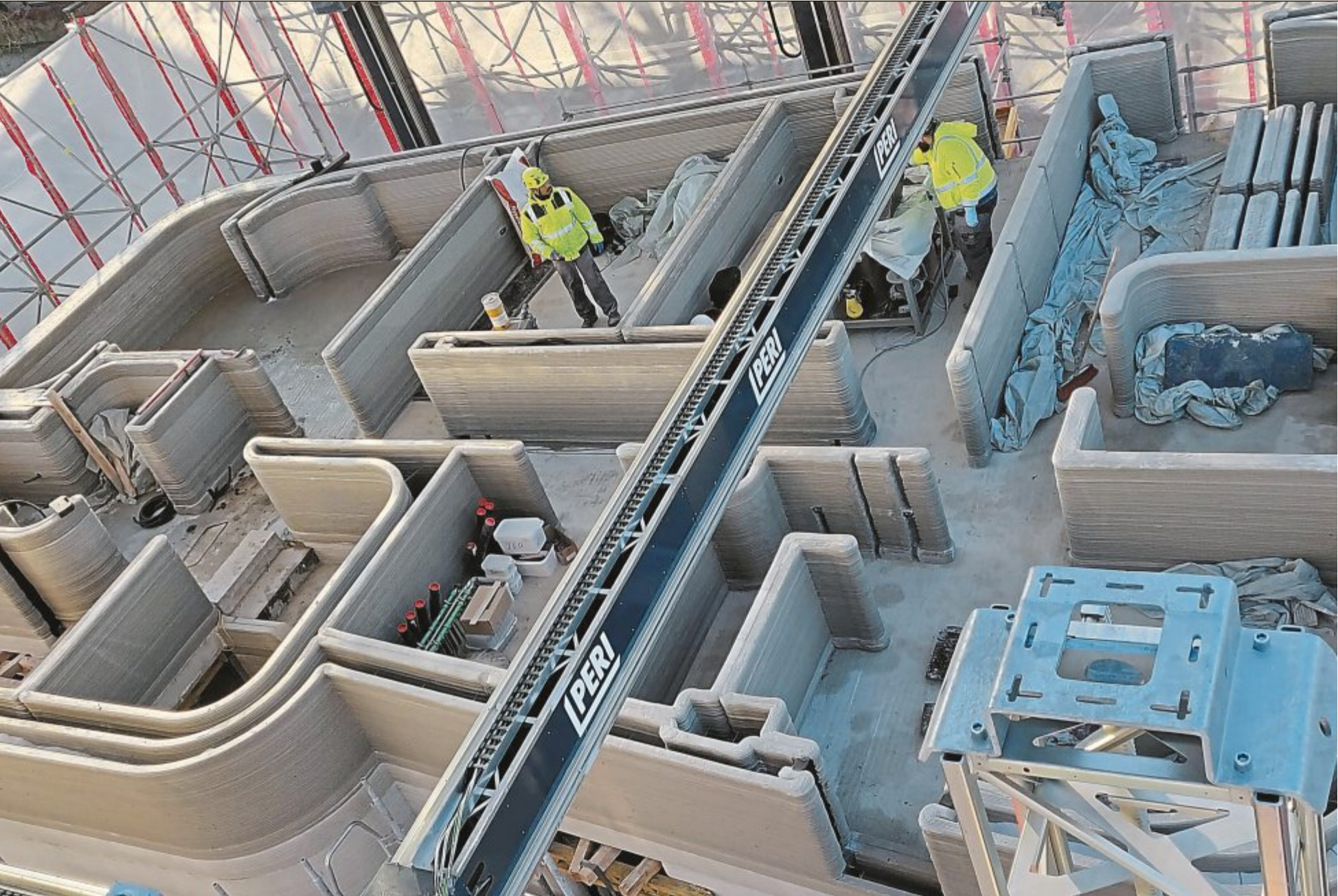
Ein Computerprogramm steuert den Drucker nach einem 3D-Modell des späteren Hauses. Aussparungen für Fenster, Türen, Kabel und Rohre sind einprogrammiert. So wächst ein Haus gleichmäßig über den gesamten Grundriss von unten nach oben.
