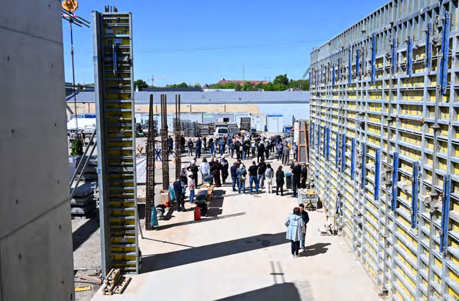
Ein Blick auf das Richtfest.
