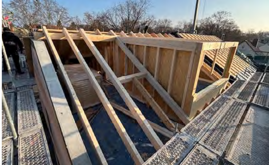
Ein Dachstuhl inklusive Gaube, eine Arbeit der Firma Gill.
