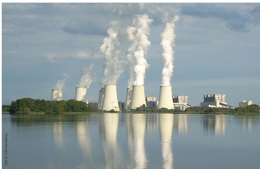
Das Kraftwerk Jänschwalde liefert auch in diesem Jahr zusätzlich Strom.
