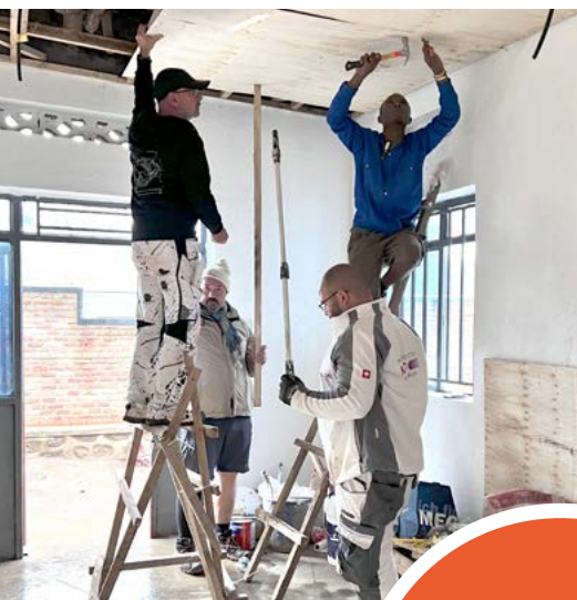
Improvisation war angesagt: Aus Mangel an Akkuschraubern musste alles genagelt werden.
