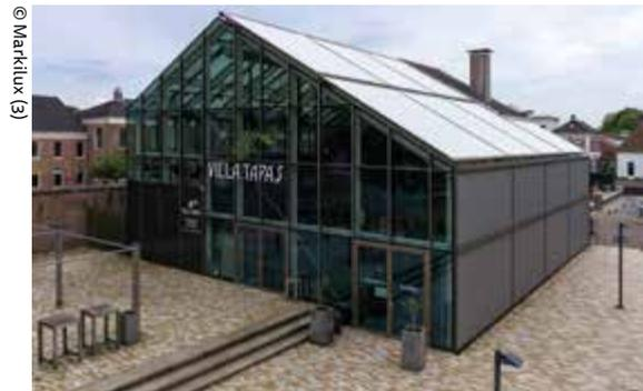
In der Kombination aus Aufglas- und Vertikalmarkisen ließ sich der Wärmeeintrag in das Gebäude deutlich reduzieren und damit Kühlenergie sparen.
