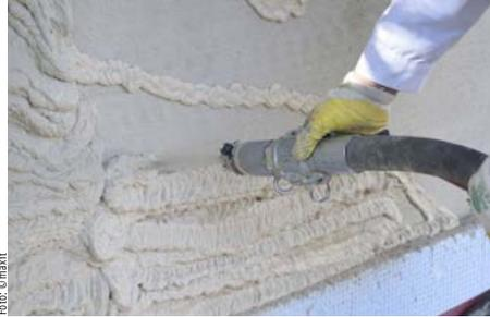
Die spritzbare Hochleistungsdämmung Ecosphere in der Anwendung.
