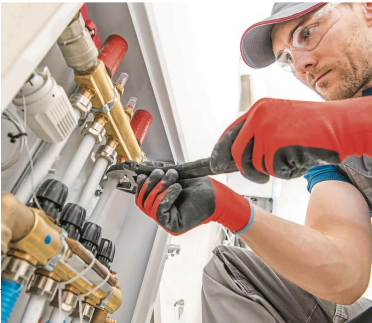
Der Installateur sollte nach Abnahme sein Werk auf Mängel überprüfen. Das muss er nicht gratis tun, sagt das OLG.
