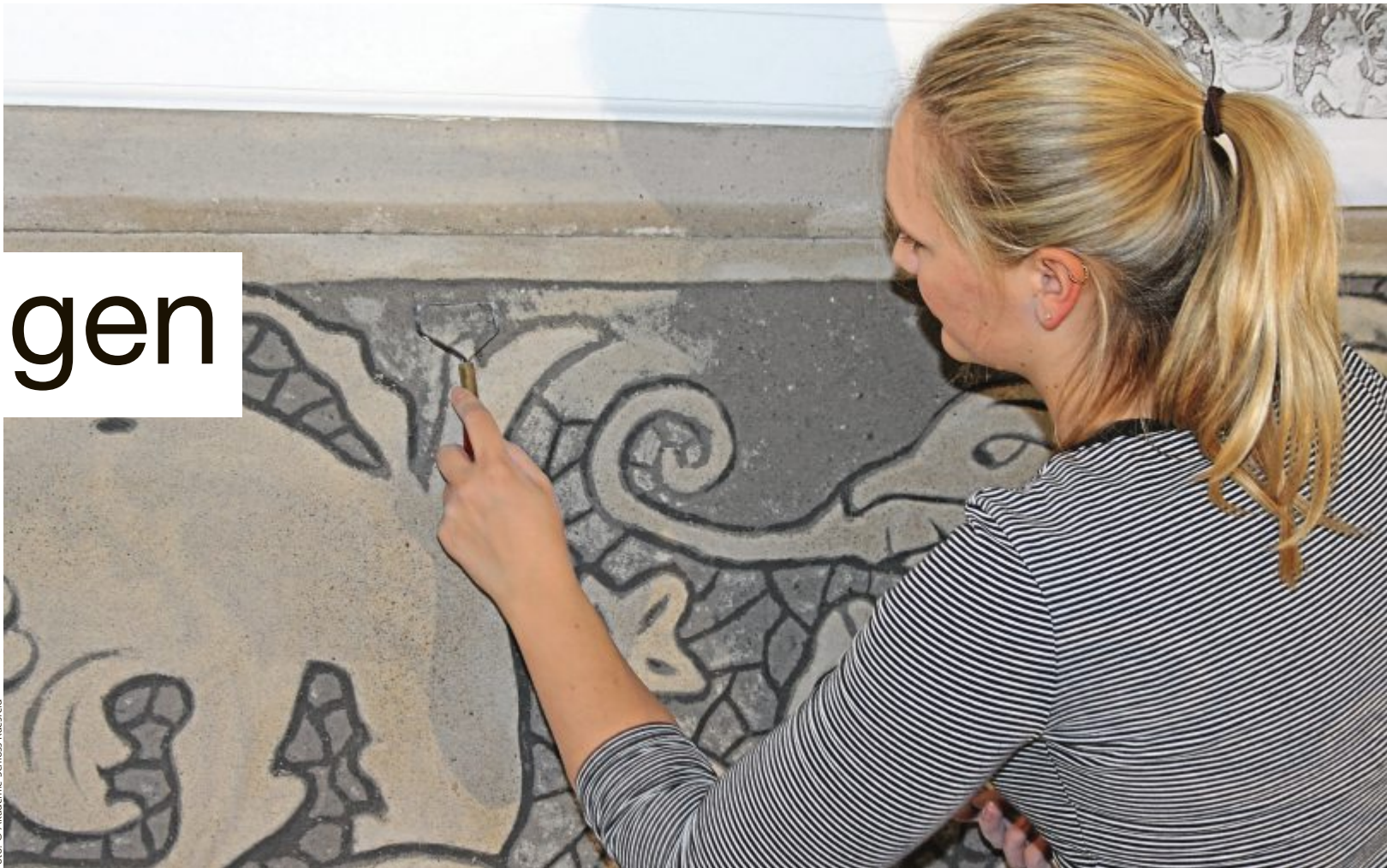
Die Rekonstruktion einer Bildarstellung mit der Sgraffitotechnik. Sgraffiare oder graffiare heißt im Italienischen so viel wie kratzen. Die Technik gibt es schon seit der Antike: Der Handwerker trägt mehrere farbige Putzschichten auf und kratzt noch im feuchten Putz Flächen wieder ab.
