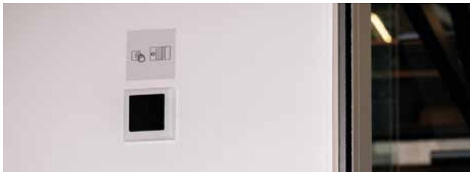
Der Näherungsschalter ermöglicht das berührungslose, hygienische Öffnen und Schließen des Schiebefensters.
