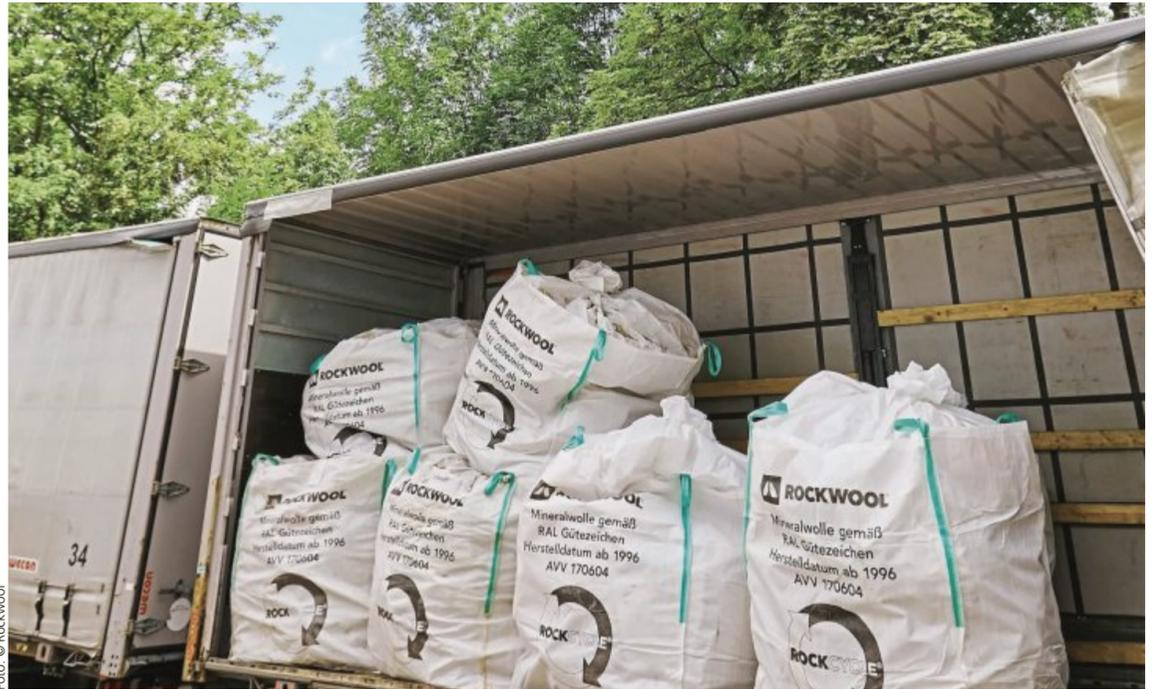
Fertig zum Recycling: Baustellenverschnitt und kleinere Mengen von Steinwolle werden in Big Bags gesammelt.
